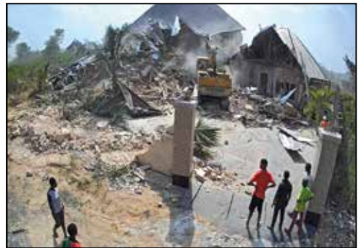
Der Bagger hat bereits den größten Teil des Hauses niedergerissen.
